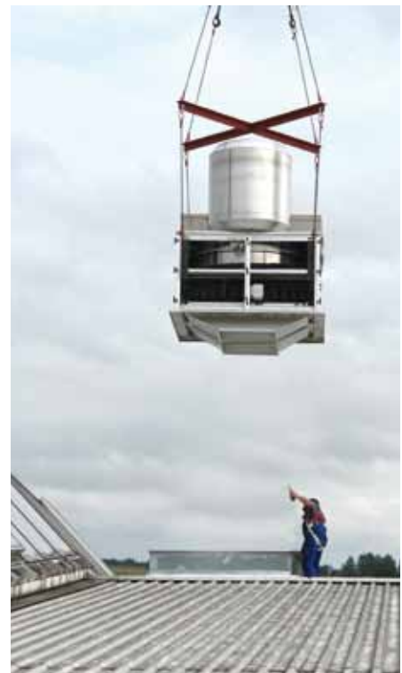
Passgenau wird der ThermoVent-D in den vorhandenen Dachsockel eingelassen und sorgfältig befestigt. Die entsprechenden
