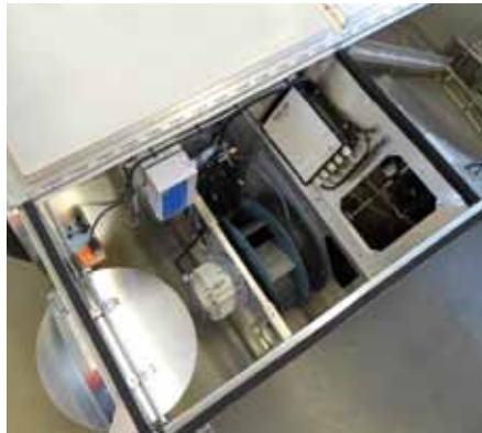
Clappen, Ventilator, Steuereinheit und Rotor
