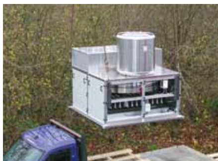
Er wird direkt vom LKW zur Montage komplett auf das Dach gehoben.
