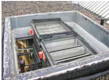
Dann wird der Sockel frei gelegt und für die Aufnahme der neuen Einheit vorbereitet.
