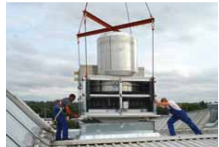
Anschlüsse für Zu- und Abluft können sogleich im Gebäudeinneren wiederhergestellt werden.
