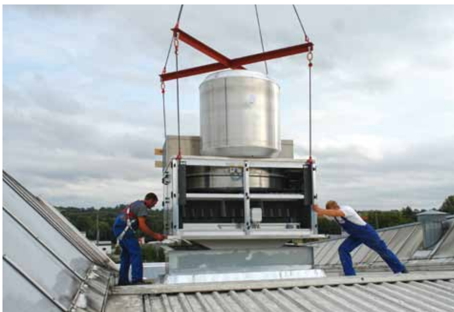
Der ThermoVent-D wird auf den vorhandenen Dachrahmen montiert
