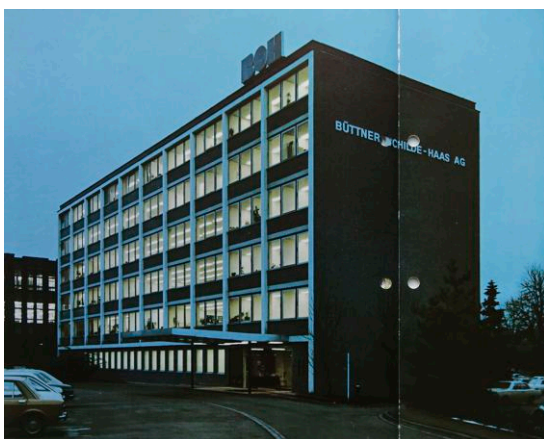
1963/64 Büroneubau, Architekten: Frank und Baumgartinger
